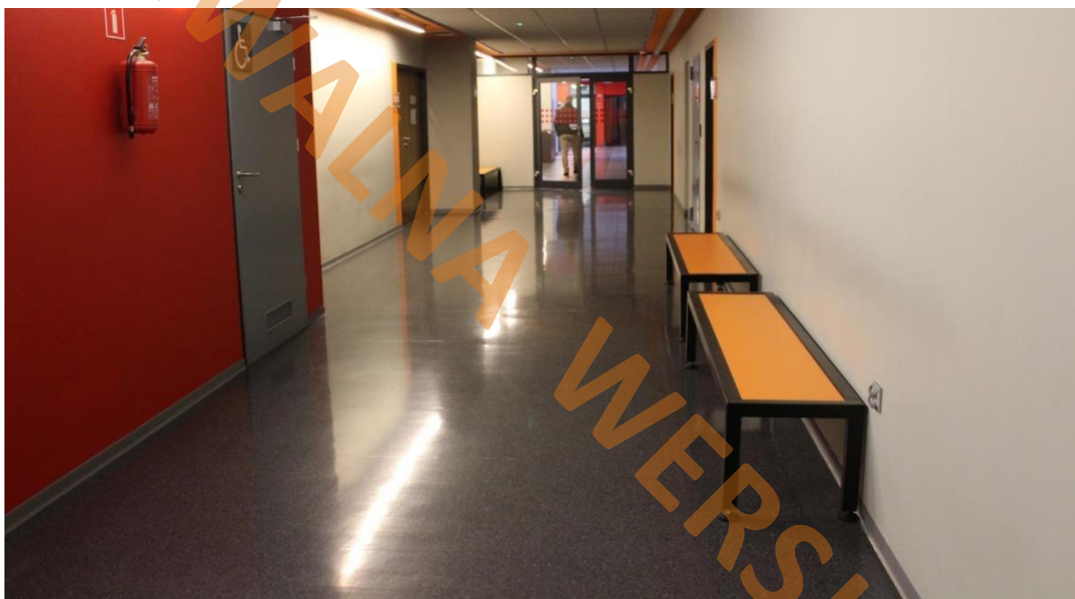
Rysunek 28. Przykład niewłaściwej powierzchni posadzki, w której odbija się światło i inne elementy [fot.: N. Ratajczak-Szponik].
