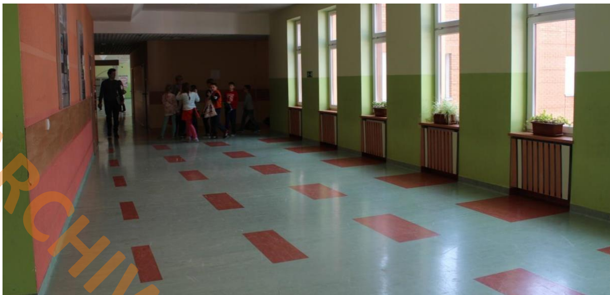
Rysunek 48. Przykład niepoprawnego stosowania wzorów na posadzkach (fot.: N. Ratajczak-Szponik).
